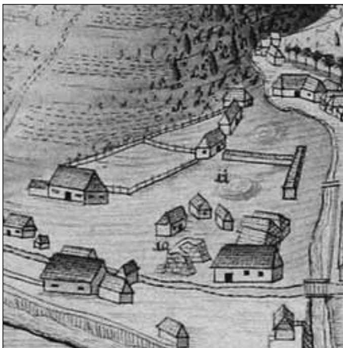
Obr. 3. Detail Horného uhliarskeho závodu v Hronci na vedute Jozefa Arvaya z roku 1765 (Zdroj: Dejiny hutníctva na Slovensku. Košice, 2006)
